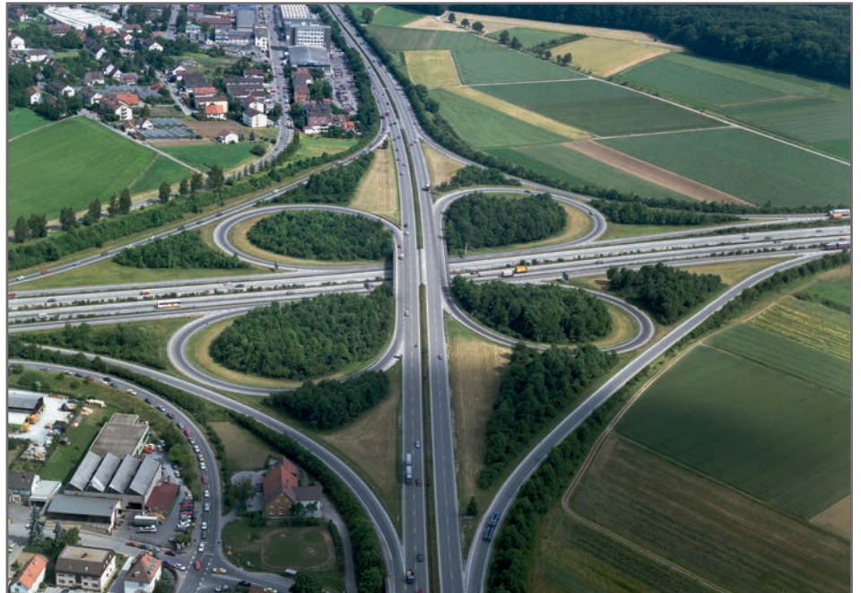
Autobahnkreuz Stuttgart-Zuffenhausen, Baden-Württemberg, Luftaufnahme.
